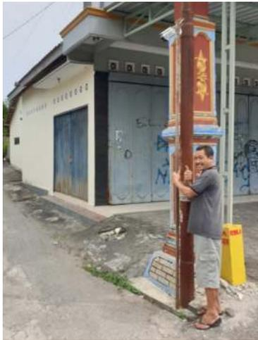
**Gambar 3. Pesangan Kamera CCTV pada Salah Satu Titik yang telah Ditentukan**
