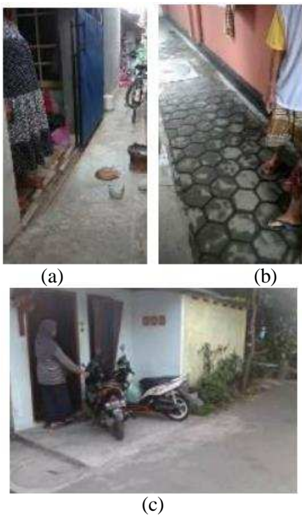
Gambar 3. (a) lahan sudah ditutup semen/plester; (b) lahan sudah ditutup konblok; (c) lahan sudah beraspal
