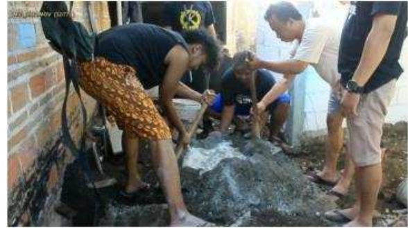
Gambar 4. Proses pembuatan percontohan toilet ramah difabel
