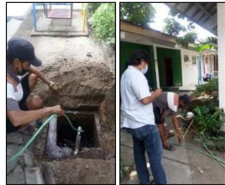
Gambar 5. (a) Pengecekan Bak Kontrol, dan (b) Pengukuran Kebutuhan Perpipaan
