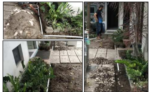
Gambar 6. Galian jalur perpipaan dan pemasangan perpipaan air bersih dan air kotor
