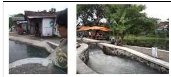
Gambar 4. Pintu Air dari Aliran "Selokan" ke Sungai Gajah Wong Sumber : Dokumentasi Pribadi, 2017
