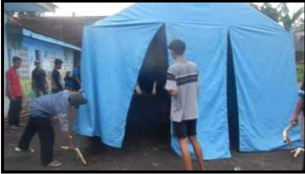
Gambar 10. Tahap Pemasangan Terpal
